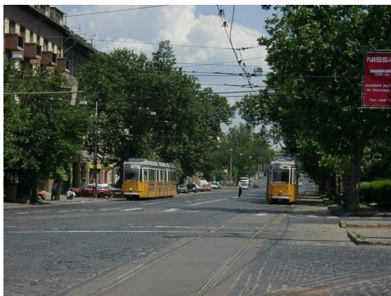
5. ábra Az átépítés előtt
